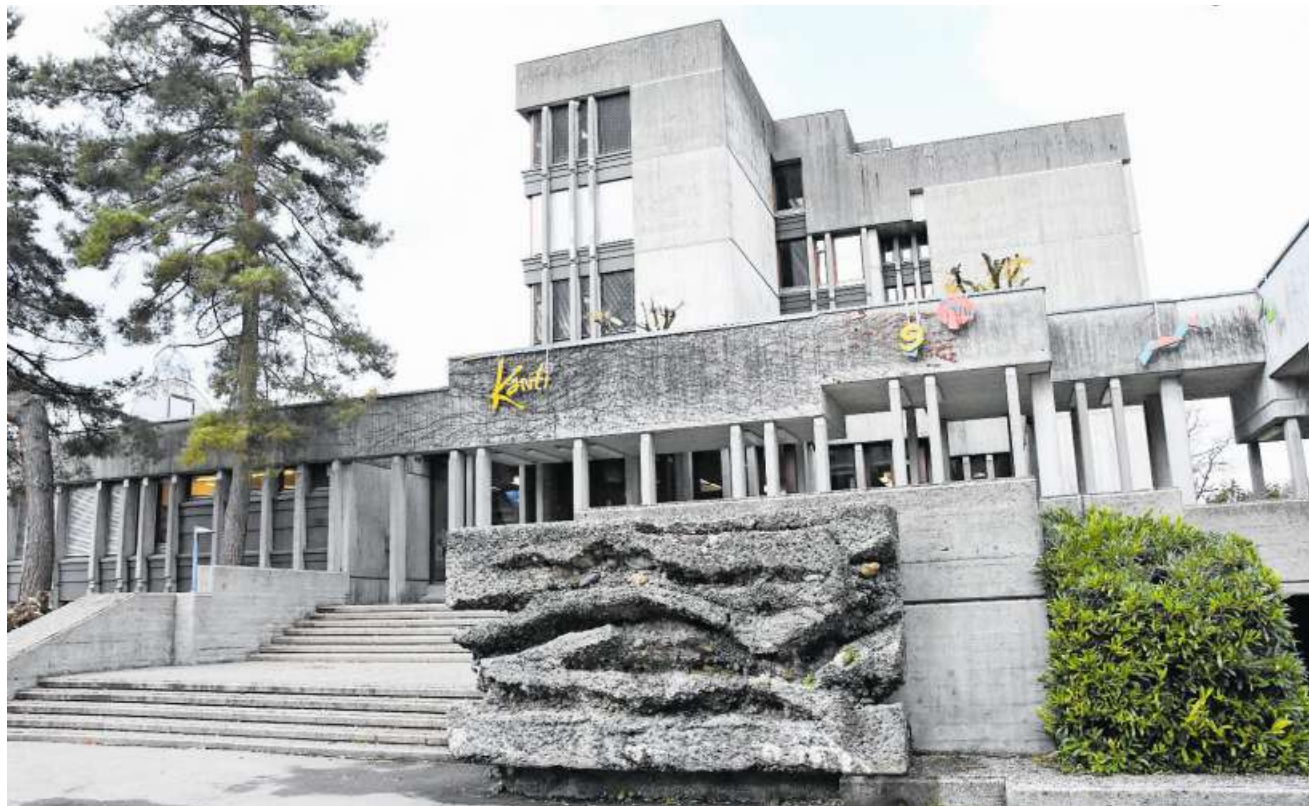
Das Gebäude der Kantonsschule ist in einem schlechten Zustand.
