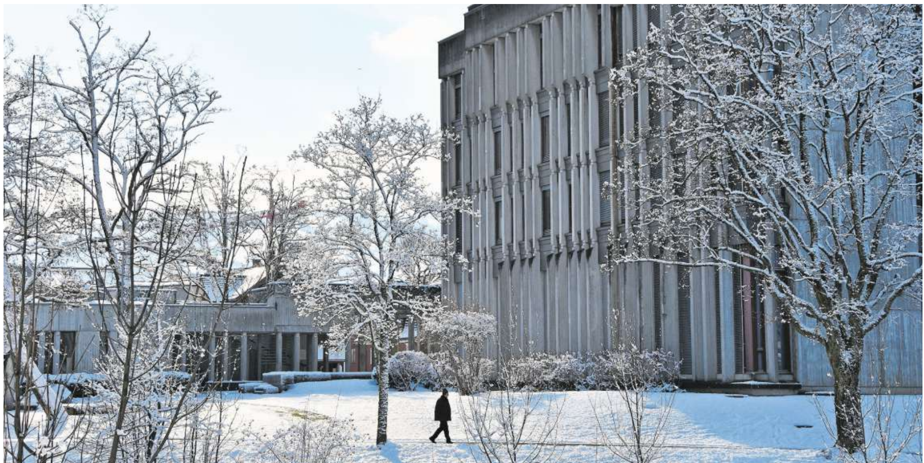
Die heutigen Gebäude der Kantonsschule Wattwil weisen laut Regierungsrat Marc Mächler eine schlechte Wärmedämmung auf.
