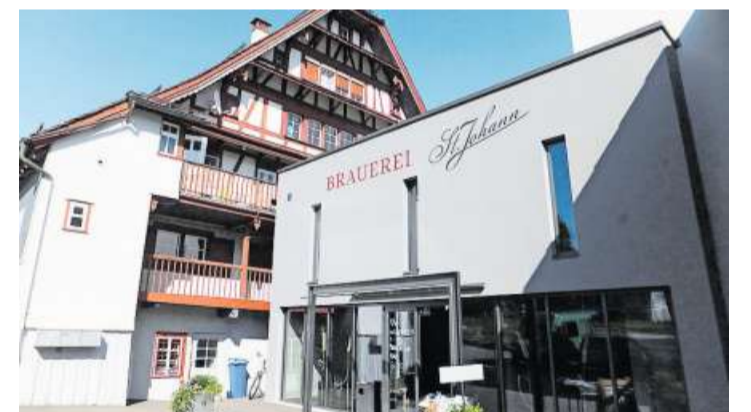
Die Bermontis wird in die Räumlichkeiten der Brauerei in Neu St. Johann einziehen.
